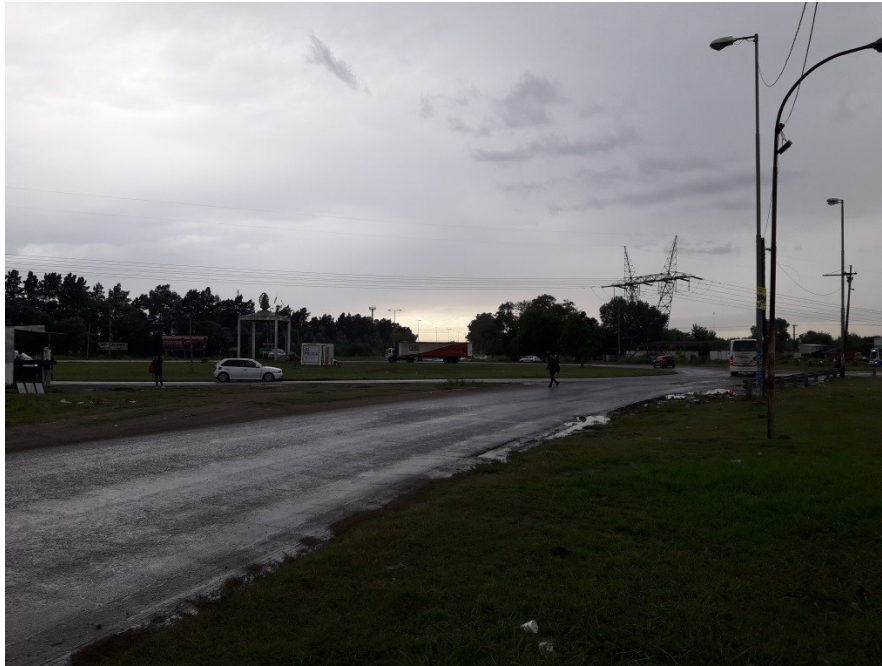
Final del tramo. Cruce con Avda. Derqui
